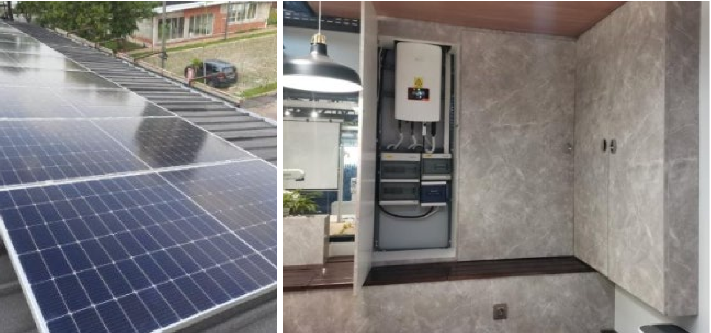
Grid-tied 5 kWp Solar Panel System at EIN Solution Center
